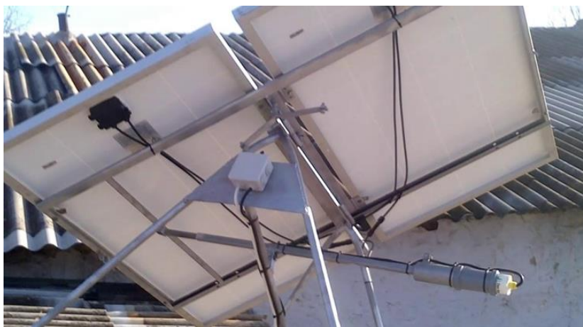
Рисунок 1.15 – Електромеханічний лінійний привід системи автоматичного позиціонування
