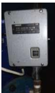
Рисунок 3.12 – Електромеханічне реле тиску РД-8Т (захист від «сухого ходу»)
