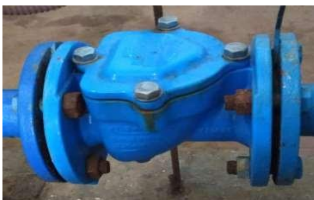
Рисунок 3.16 – Зворотний клапан у розрізі (без можливості моніторингу положення)
