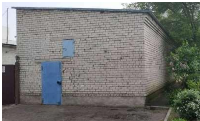
Рисунок 3.8 – Екстер'єр та архітектурне виконання наземної будівлі насосної станції
