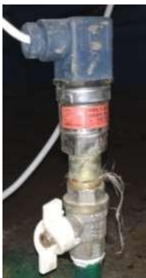
Рисунок 3.14 – Вимірювальний перетворювач (датчик) тиску на напірному колекторі
