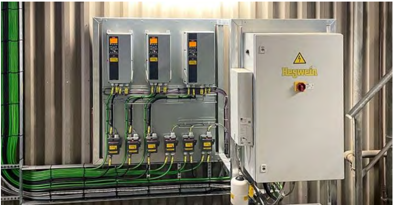
Рис 2.5 Силова частина запальника Hegwein
