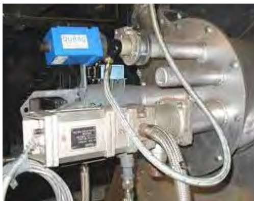
Рис 2.1 Система DURAG+HEGWEIN на котлі
